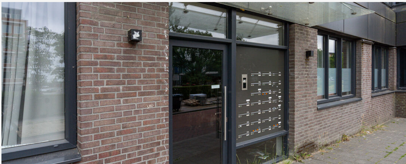
Entree/hal met brievenbussen en toegang tot de lift
