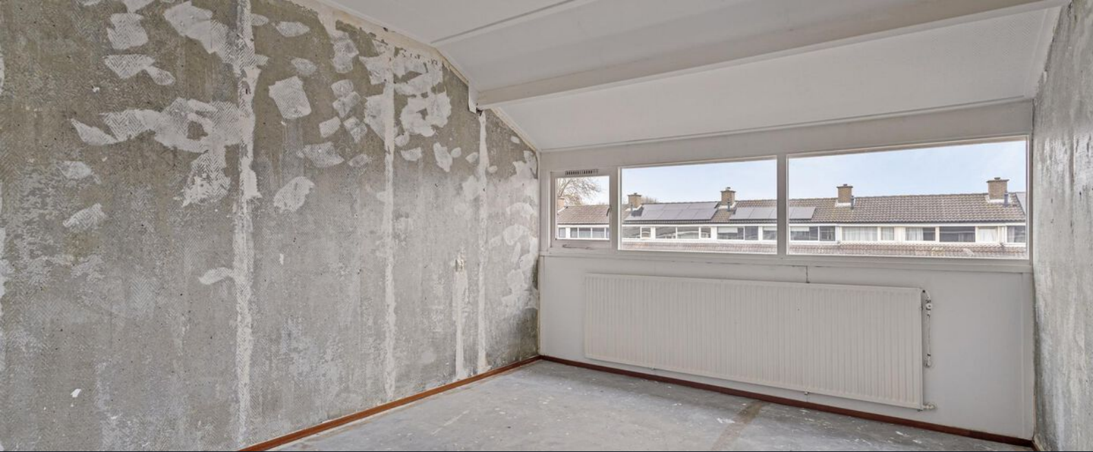
Ruime zolderkamer met dakkapel.
